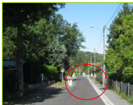
Passage étroit pour piétons et vélos
