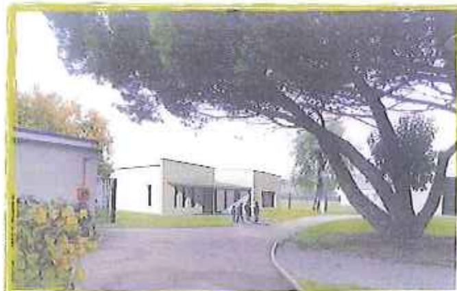
Extension de l'école primaire Jacqueline AURIOL. Construction de 2 classes complémentaires d'une superficie de 158 m 2 , raccordées à l'existant par le couloir après démolition de l'ancien préfabriqué.
