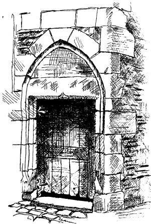
porte XVème : arc de décharge en tiers-point (1 clef, 2 voussoirs, 2 sommiers), linteau droit avec feuillure
