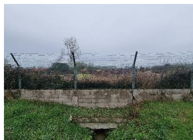
Clôture haute autour du dépôt
