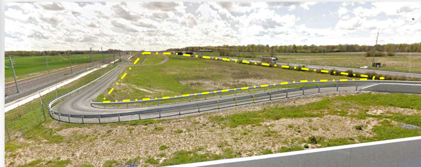
3.2 – vue Nord Est depuis le pont de la route de Thilouze après la réalisation de la LVG
