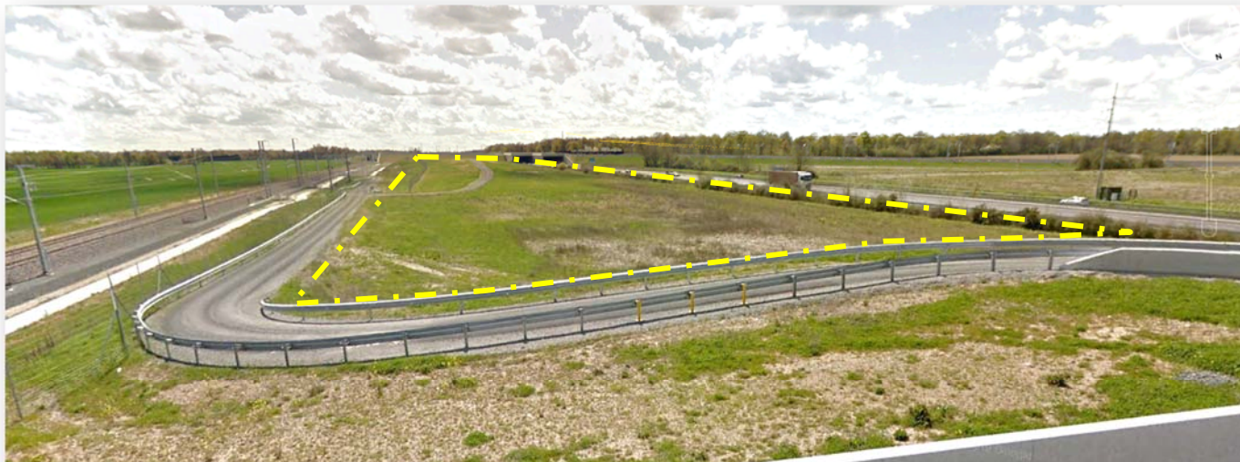
1- AVANT INSTALLATION DU PARC PHOTOVOLTAIQUE / Vue depuis le pont de la route de Thilouze après la réalisation de la LVG
