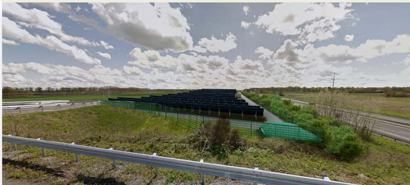
2- APRES INSTALLATION DU PARC PHOTOVOLTAIQUE / Vue depuis le pont de la route de Thilouze après la réalisation de la LVG
