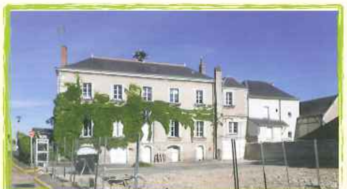
Cour de la mairie après démolition
